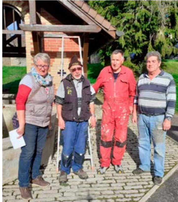
Rénovation du lavoir par les bénévoles
